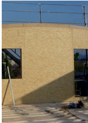
Elementbau Die schnelle und präzise Bauweise!
