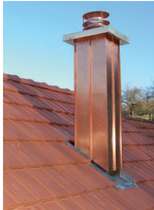
Bedachungen Ein dichtes Dach ist ein Grundbedürfnis!
